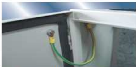
Sistema para puesta a tierra bisagras atornillables
